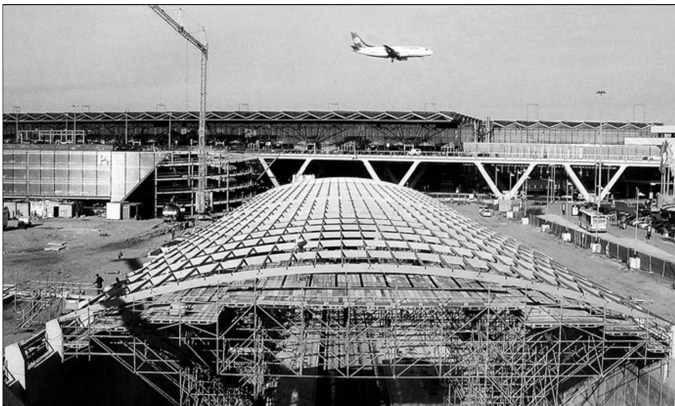
Рис. 1. Возведение сводчатого покрытия над станцией в аэропорту Кёльн/Бонн
