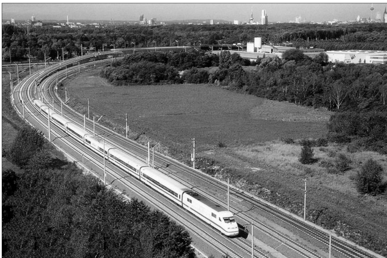
Рис. 5. Общий вид участка линии к аэропорту Кёльн/Бонн в районе Франкфуртер-Штрассе
