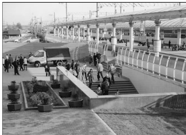
Рис. 2. Пересадочный узел Выхино после реконструкции
