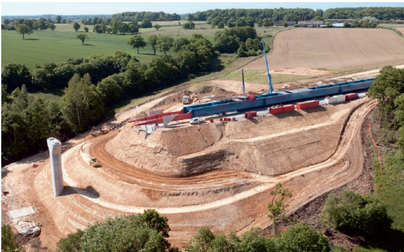
Рис. 3. Строительство моста на линии LGV Bretagne-Pays de la Loire (фото: Eiffage)
