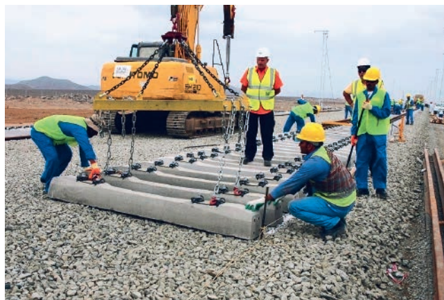
Рис. 2. Укладка пути в рамках второго этапа проекта ННСР
