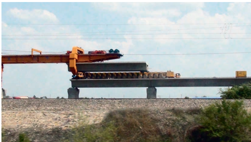
Рис. 2. Строительные работы на линии Харбин – Далянь
