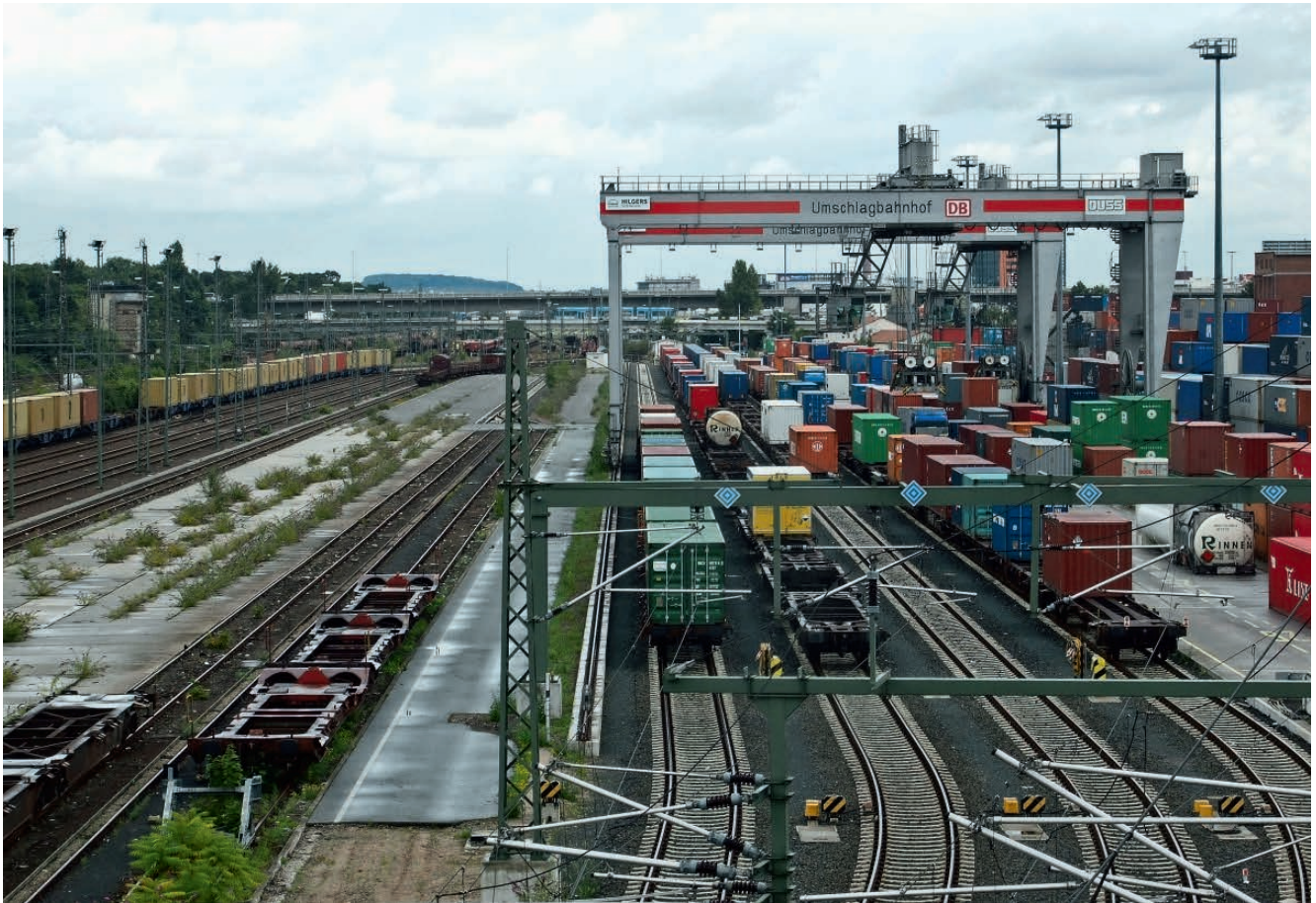
Рис. 2. Контейнерный терминал с вертикальной перегрузкой во Франкфурте-на-Майне
