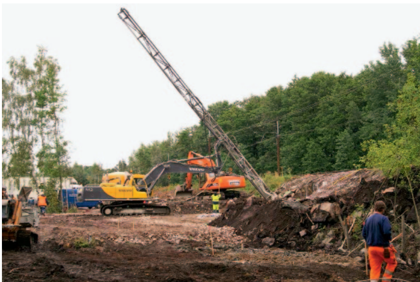
Установка наклонной цементно-известковой колонны для усиления земляного полотна
