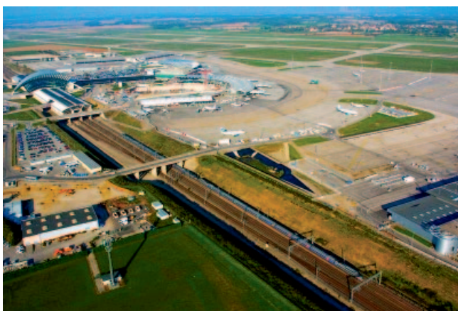
Рис. 2. Здесь будет сооружен терминал Lyon Carex
