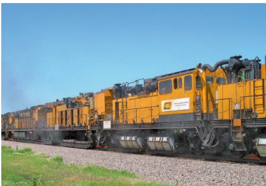
Рис. 1. Работа рельсошлифовального поезда компании Logam на одном из участков железной дороги Union Pacific
