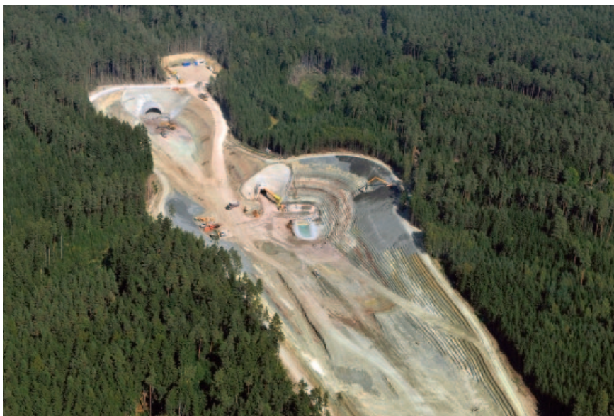
Рис. 1. Начало строительства тоннеля Höhnberg
