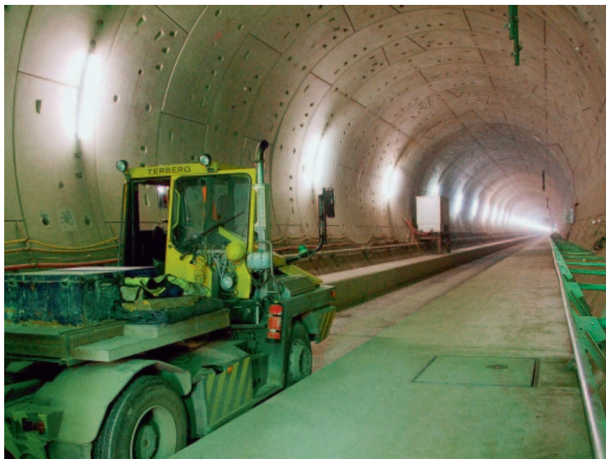
Рис. 3. Один из готовых участков тоннеля Katzenberg перед началом укладки пути
