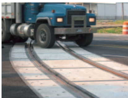
Рис. 1. Настил из панелей компании Century Group для переезда в криволинейном участке пути с движением тяжелых грузовых автомобилей (фото: Century Group)
