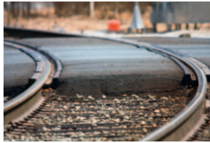
Рис. 3. Переезд с уплотнениями типа HiRAIL RS компании HiRAIL (фото: HiRAIL)
