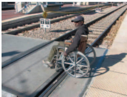
Рис. 2. Настил из панелей компании Century Group для пешеходного перехода, приспособленного для лиц на инвалидных колясках (фото: Century Group)
