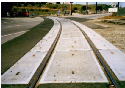
Рис. 5. Настил из панелей компании Omega Industries для переезда через криволинейный участок пути (фото: Omega Industries)
