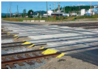
Рис. 8. Переездный настил из панелей компании Rail-Way (фото: Rail-Way)
