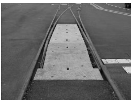
Рис. 6. Настил из панелей компании Omega Industries для переезда через стрелочный перевод (фото: Omega Industries)
