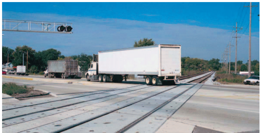
Рис. 4. Переездный настил из панелей компании KSA (фото: KSA)
