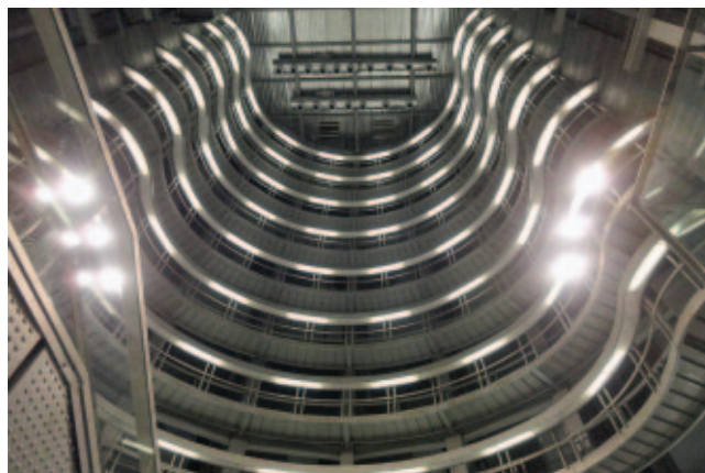
Рис. 3. Лифтовая шахта одной из новых станций
