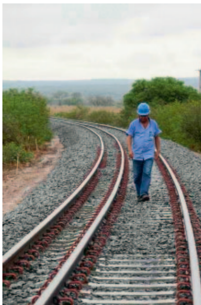
Рис. 2. Один из готовых участков с совмещенной колеей
