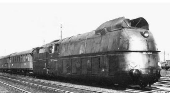
Рис. 1. Паровоз серии 05 компании Borsig с оптимизированной с точки зрения аэродинамики формой (фото 1936 г.)
