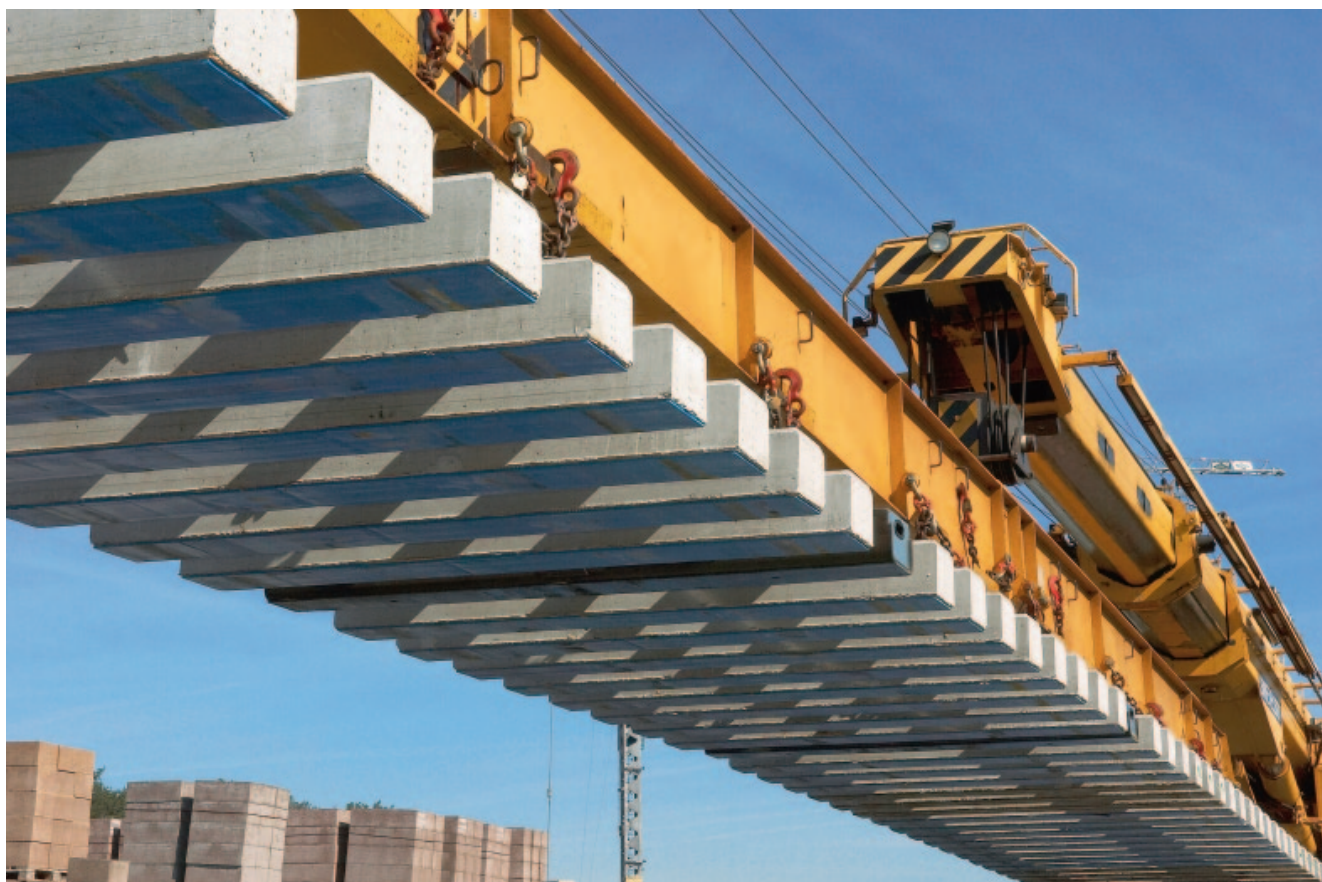
Рис. 2. Железобетонные шпалы с упругими подкладками (фото: Getzner Werkstoffe)
