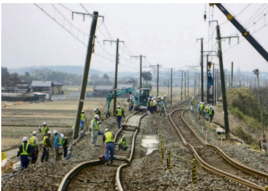
Рис. 2. Восстановительные работы на одной из линий JR East
