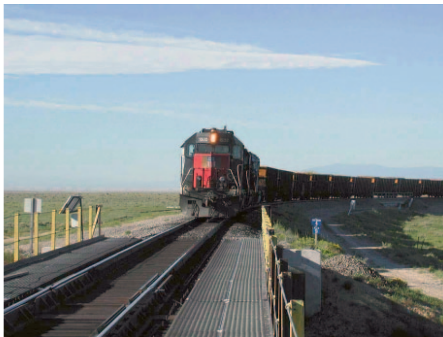
Рис. 3. Участок полигона FAST с мостом для изучения взаимодействия инфраструктуры и подвижного состава
