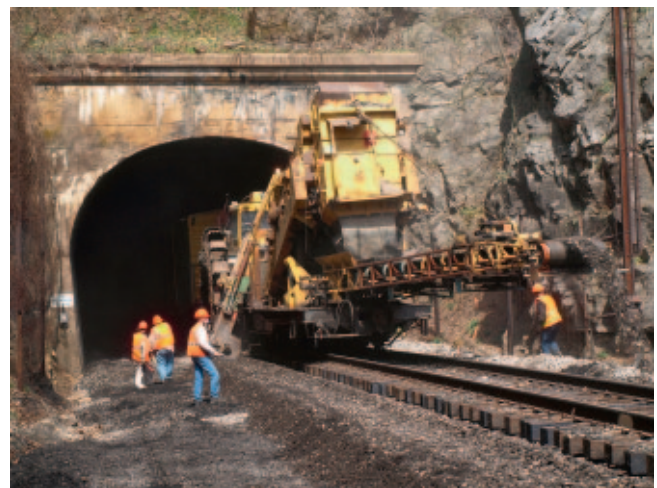
Рис. 6. Работы по понижению уровня пути в тоннеле Eggleston коридора Heartland
