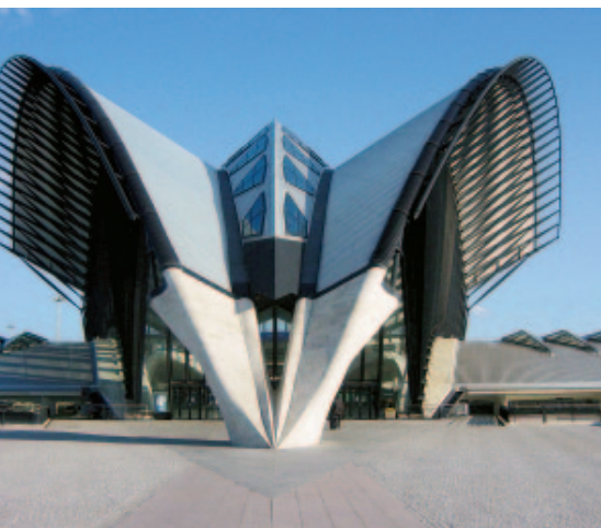
Рис. 3. Наземный вестибюль вокзала в аэропорту Лион-Сент-Экзюпери
