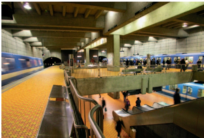
Рис. 5. Двухъярусная пересадочная станция Лионель-Гру метрополитена Монреаля
