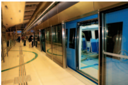
Синхронная работа вагонных и платформенных дверей
