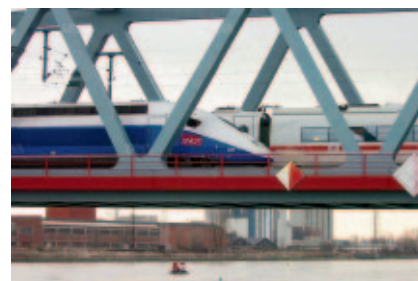
Рис. 7. Высокоскоростные поезда TGV и ICE на мосту через Рейн
