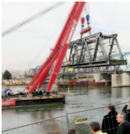
Рис. 5. Демонтаж пролетных строений старого моста
