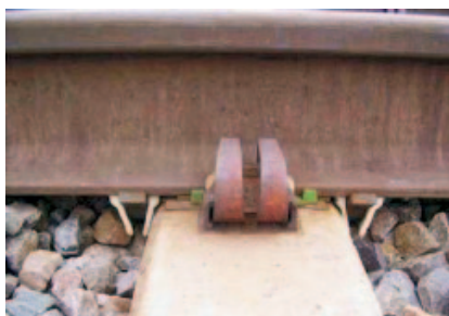
Рис. 2. Железобетонная шпала и рельс с противоугонами
