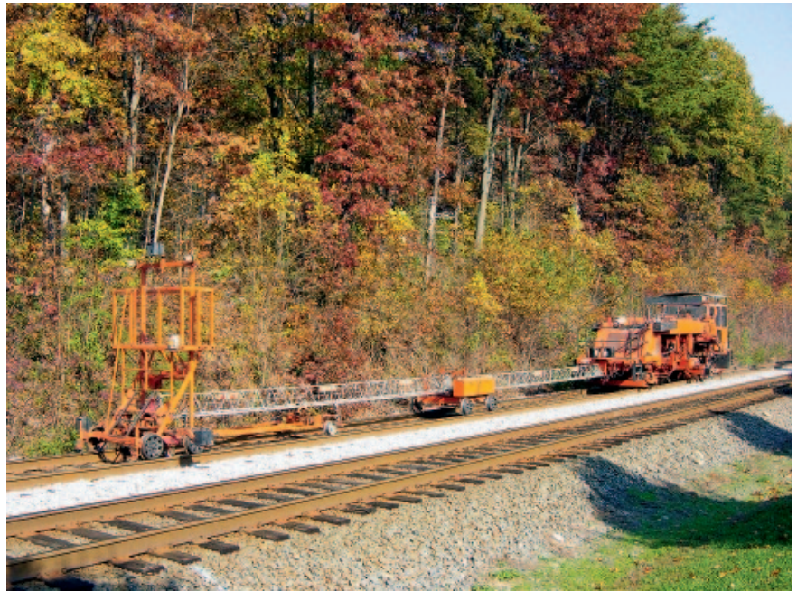
Рис. 4. Подбивочно-выправочная машина с лазерным контролем на линии железной дороги NS в районе г. Рейвен, штат Виргиния (США)
