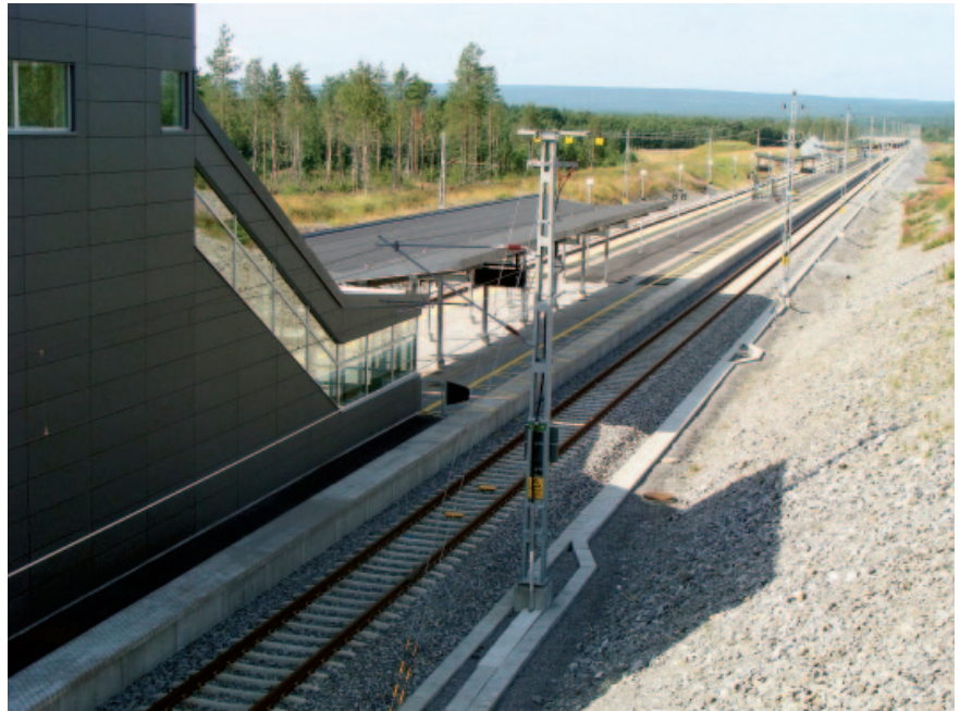
Рис. 2. Станция Умео на линии Botniabanan (фото: Norrtåg)
