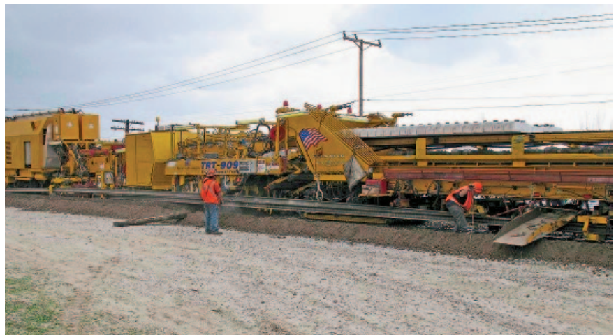
Рис. 8. Работа направляющего устройства при перемещении рельсов
