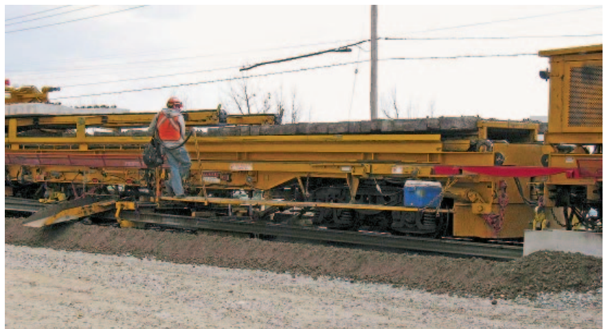
Рис. 7. Конвейер для перемещения старых шпал
