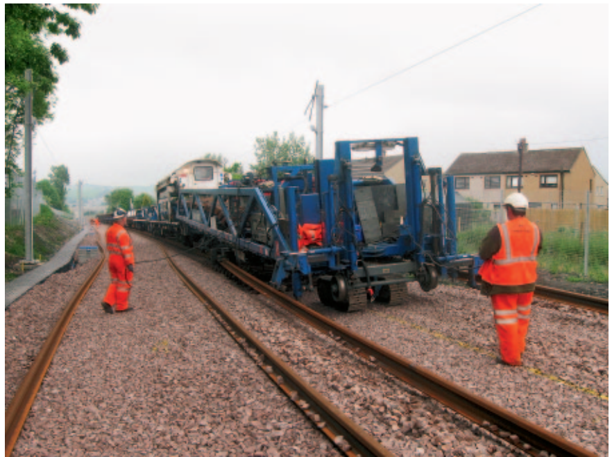
Рис. 2. Работы по укладке пути на участке Эрдри — Батгит (фото: Network Rail)
