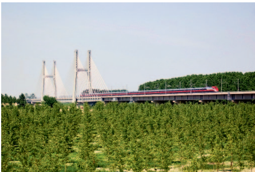
Рис. 1. Поезд категории Frecciarossa на подходе к новому мосту через р. По на высокоскоростной линии Болонья — Милан
