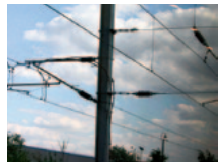
Рис. 1. Изоляторы кронштейна и тяги
