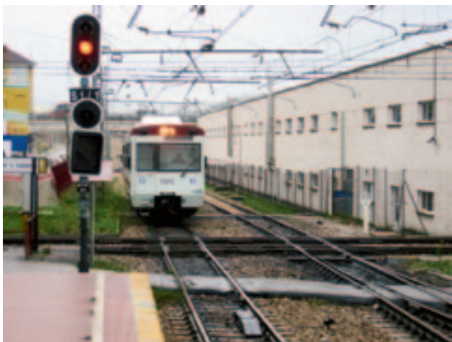
Рис. 9. Пересечение в одном уровне двух узкоколейных линий в районе Хихона
