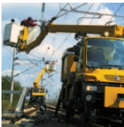
Рис. 5. Монтаж контактной подвески с помощью машин на комбинированном ходу
