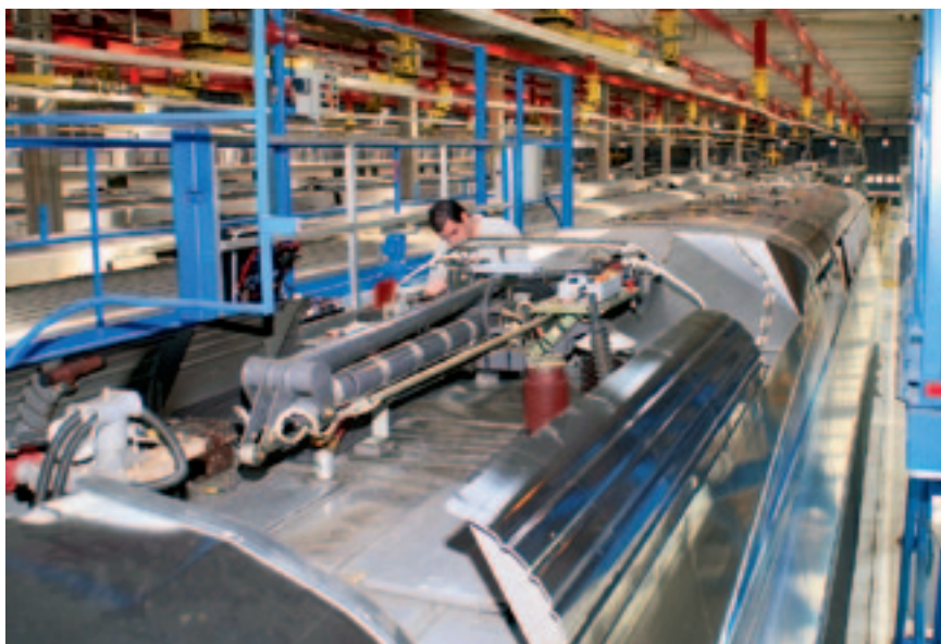
Рис. 5. Обслуживание поезда TGV Duplex в техническом центре Восточноевропейский
