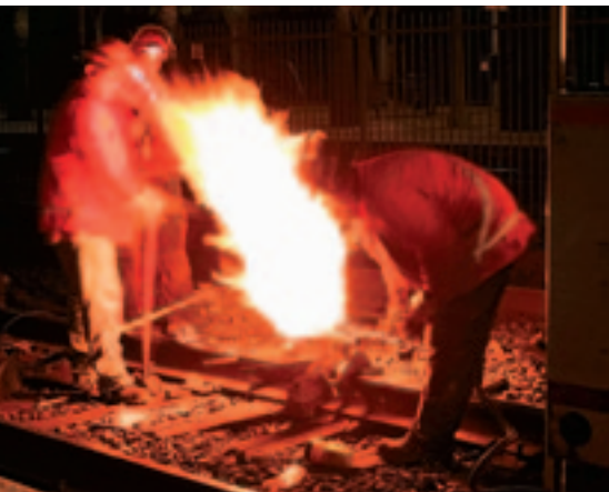
Рис. 1. Устранение дефекта сварного рельсового стыка с помощью установки Gap Weld
