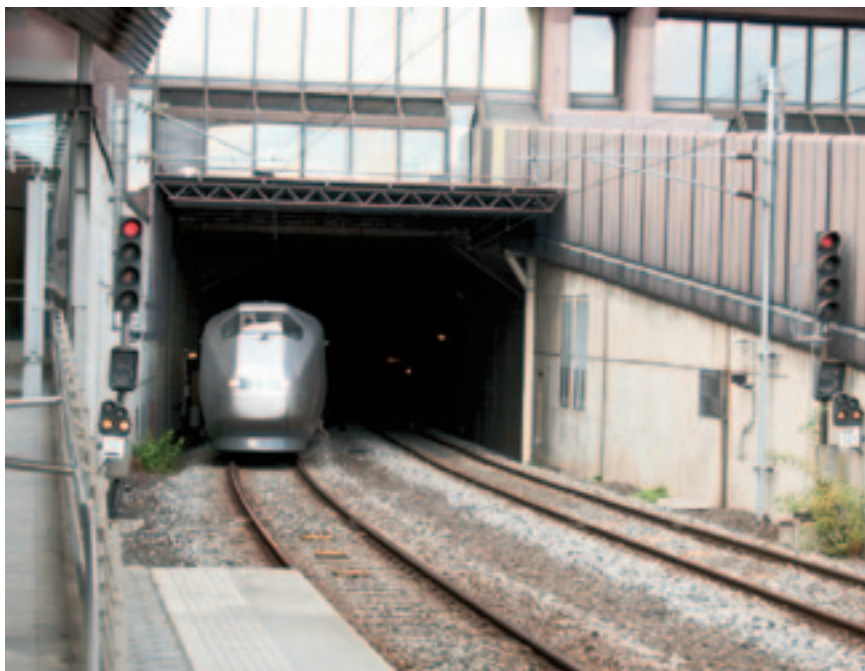
Рис. 2. Один из порталов железнодорожного тоннеля в Осло
