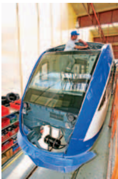
Рис. 10. Электромонтажные работы на поезде Coradia Lint (фото: Alstom, В. Розенталь)
