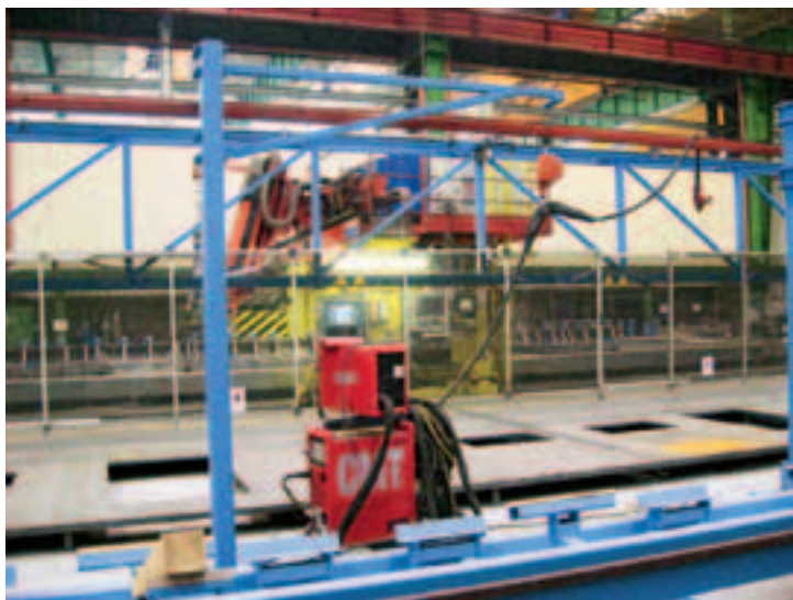
Рис. 3. Участок лазерной сварки
