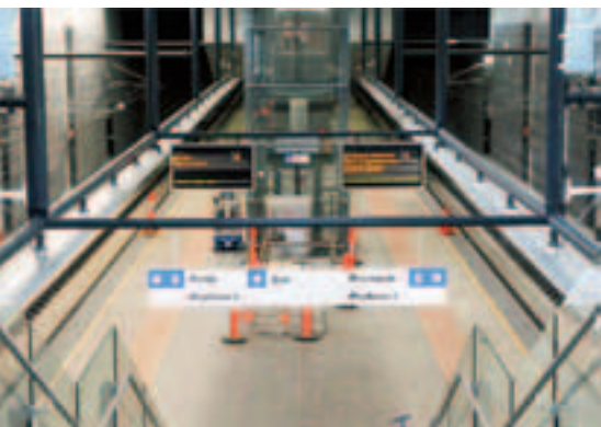
Рис. 4. Подземная станция Эспленейд в центре Перта
