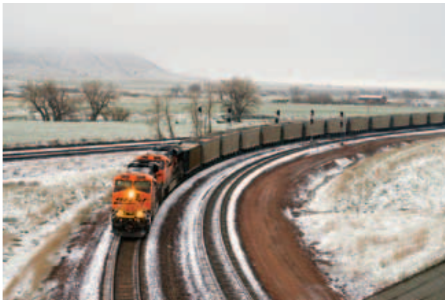
Рис. 5. Участок Оринской линии на железобетонных шпалах
