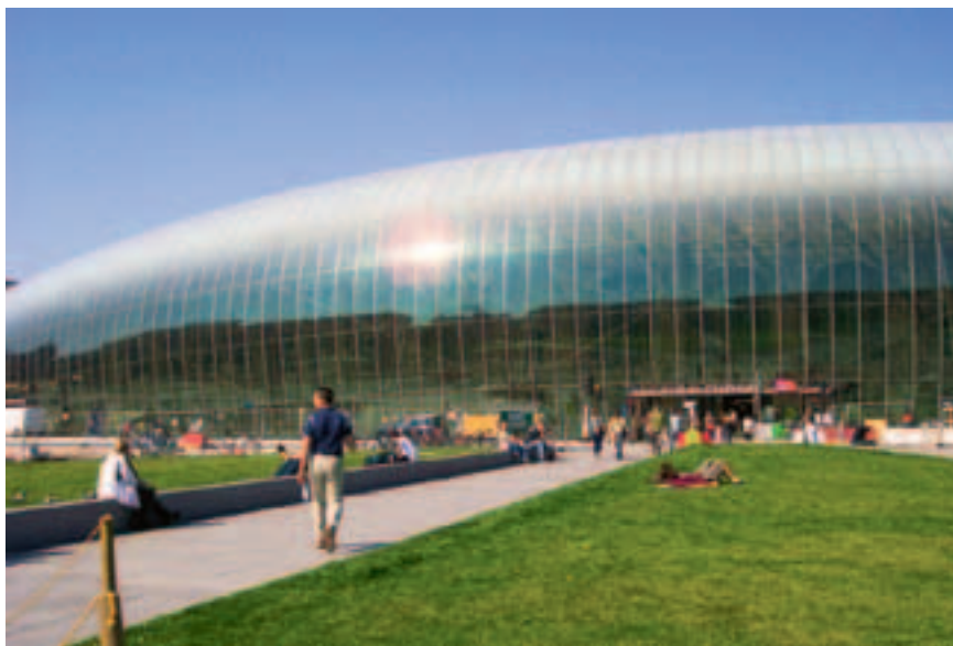
Рис. 3. Внешний вид вокзала Страсбура после реконструкции
