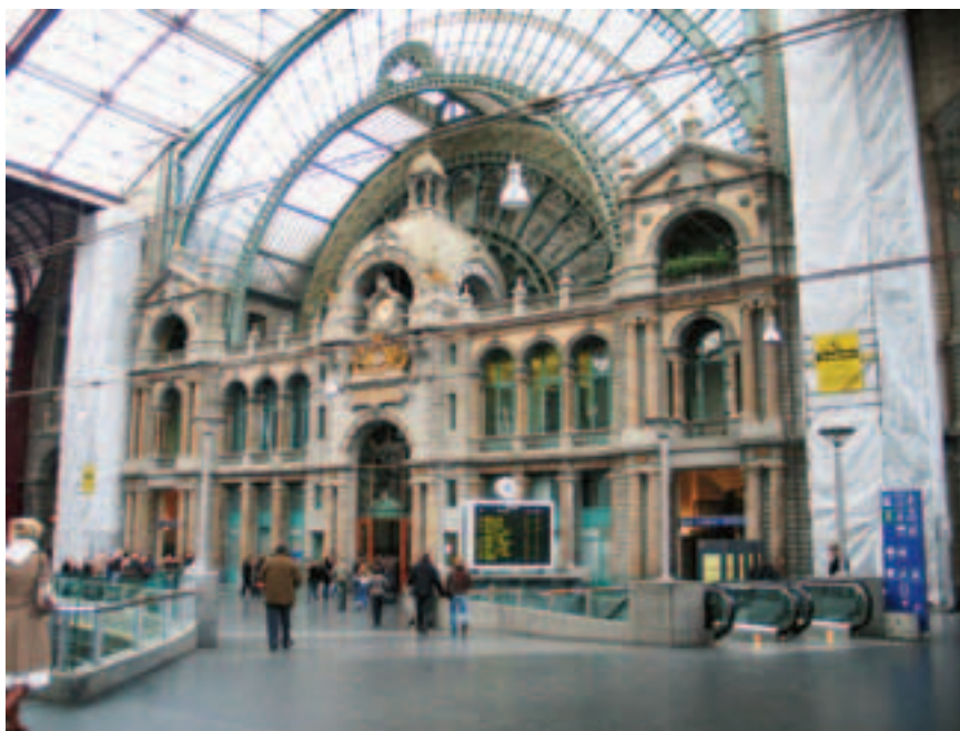
Рис. 11. Интерьер реконструированного вокзала Антверпен-Центральный с сохраненными фрагментами старого здания
