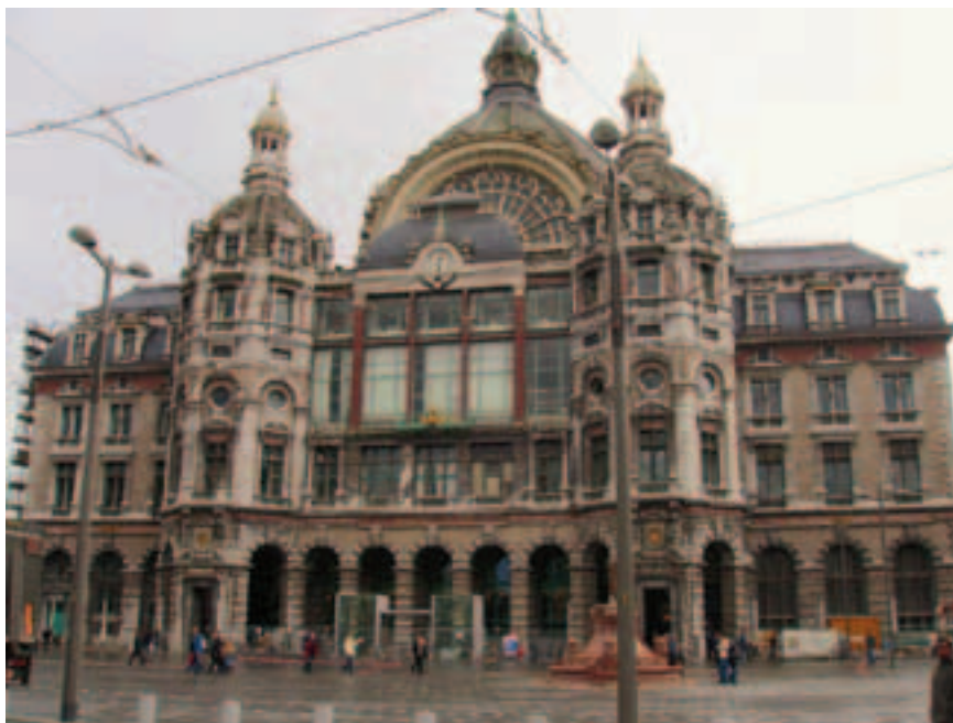
Рис. 10. Старое здание вокзала Антверпен-Центральный
