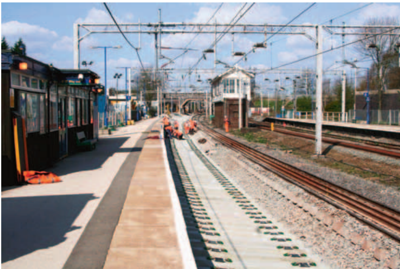
Рис. 6. Работы по укладке дополнительных путей на участке Армитидж — Тамуэрт (фото: Network Rail)
