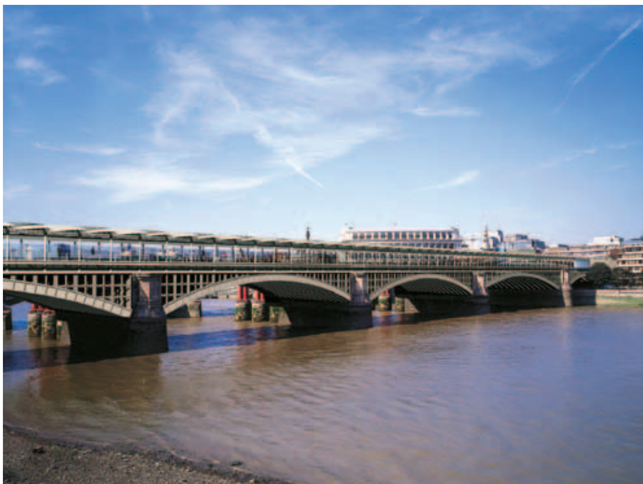
Рис. 9. Станция Блэкфрайерс по завершении первого этапа реконструкции (фото: Network Rail)
