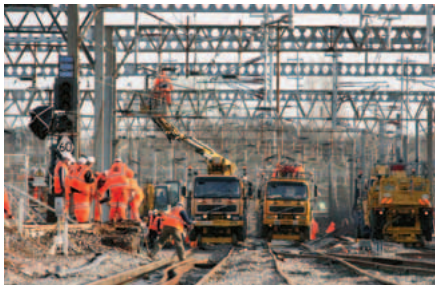
Рис. 4. Работы по реконструкции инфраструктуры в узле Рагби (фото: Network Rail)
