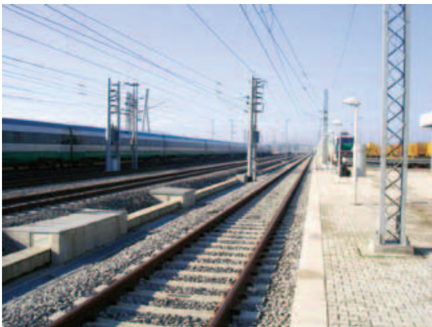
Рис. 1. Новая высокоскоростная линия Рим — Неаполь железных дорог Италии, оснащенная системой ETCS уровня 2
