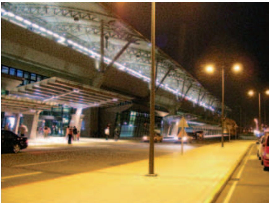
Рис. 3. Станция Тайчжун линии THSR
