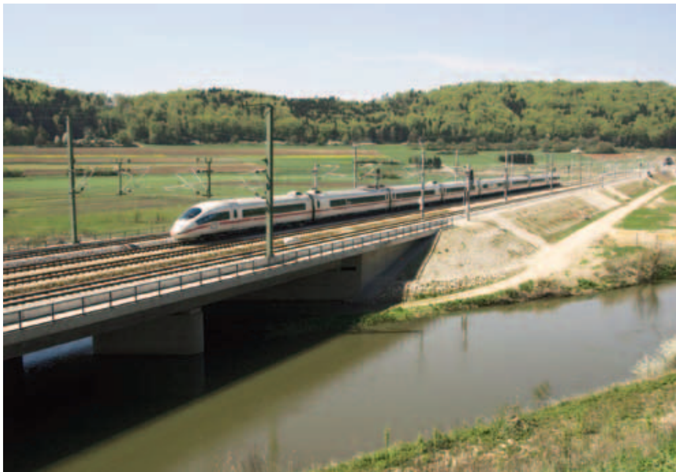
Рис. 2. Мост через реку Альтмюль (фото: DB, X.-А. Кирше)
