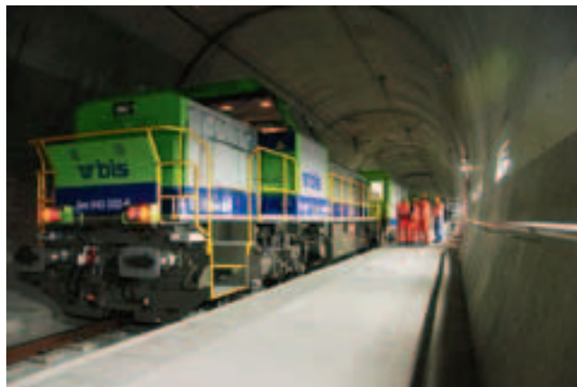
Рис. 2. Рабочий поезд в Лёчбергском базовом тоннеле
