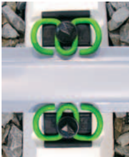
Рис. 5. Типовое клеммное рельсовое скрепление компании Vossloh
