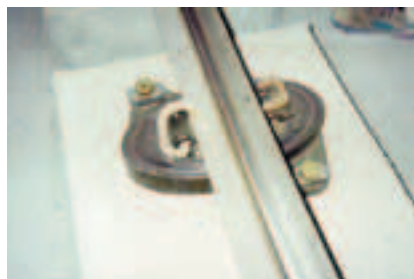
Рис. 1. Рельсовое скрепление типа Egg компании АТР
