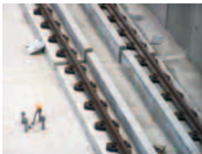
Рис. 2. Путь с рельсовыми скреплениями типа F20R2 компании L. B. Foster
