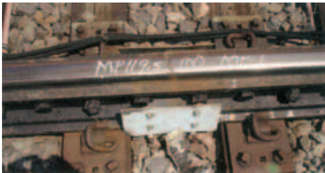
Рис. 1. Изолирующий стык с охватывающими накладками
