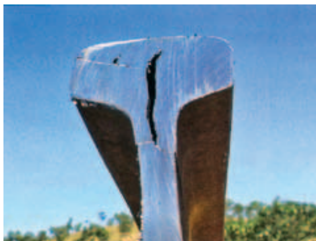
Рис. 8. Вертикальная трещина в головке рельса из-за шлакового включения
