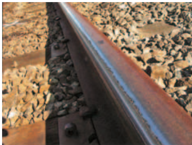
Рис. 6. Полоса контакта на поверхности катания рельса в кривой
