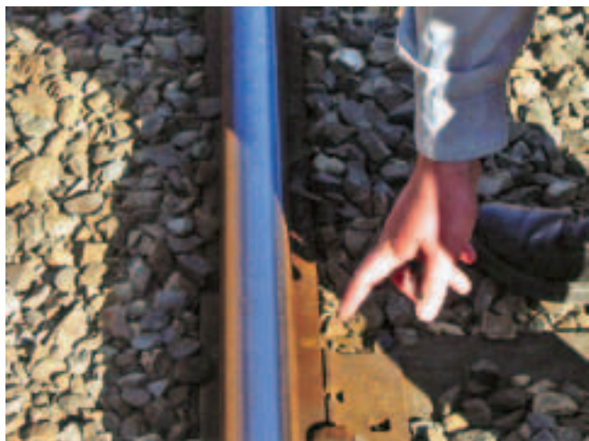
Рис. 5. Полоса контакта на поверхности катания рельса в прямой
