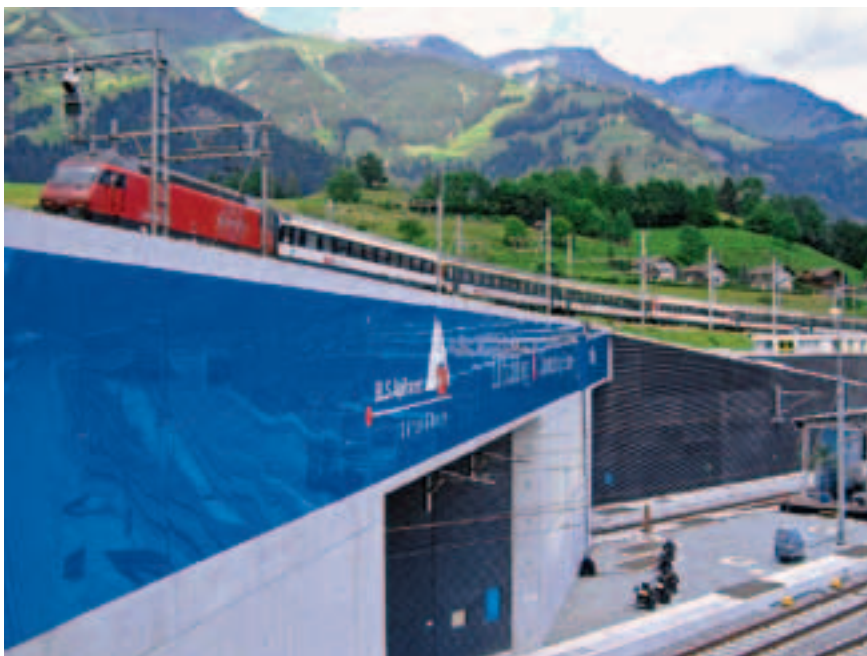
Рис. 2. Поезд верховой линии проходит над порталом базового тоннеля
