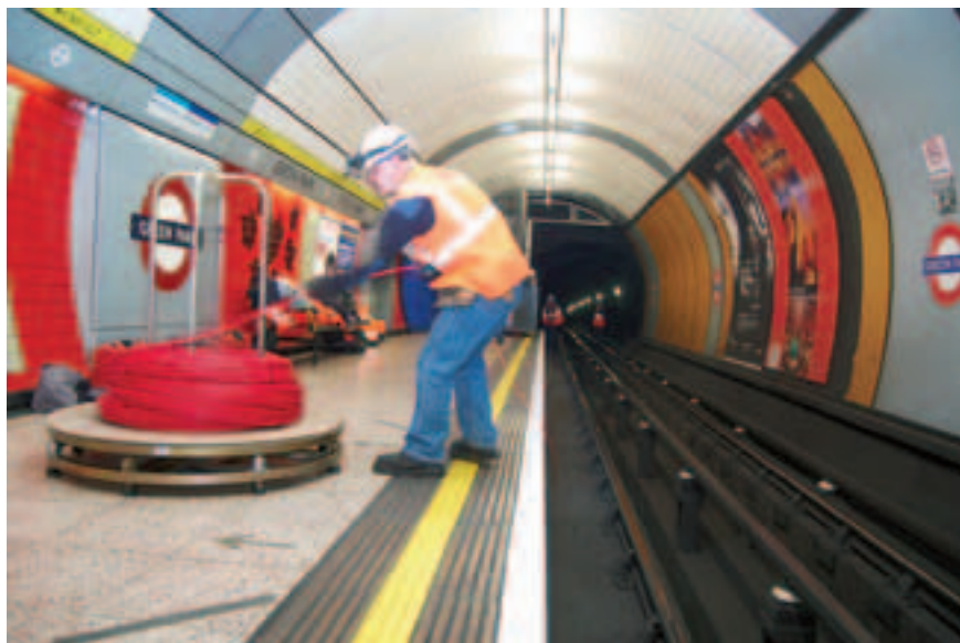
Рис. 3. Кабельные работы на реконструированной станции Грин-Парк линии Jubilee (фото: TL)
