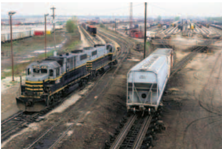
Рис. 1. Общий вид сортировочной станции Клиринг
