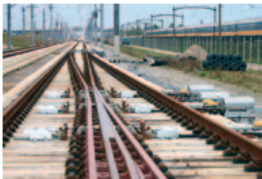
Рис. 6. Стрелочный перевод для высокоскоростного движения с несколькими приводами L826H компании Alcatel, подключенными к управляющему стрелочному модулю Siwes 2 компании Siemens
