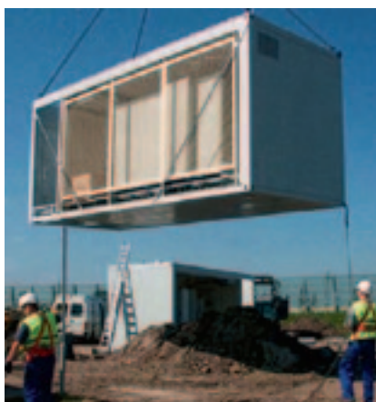
Рис. 4. Установка контейнера с оборудованием МПЦ на линии HSL-Zuid
