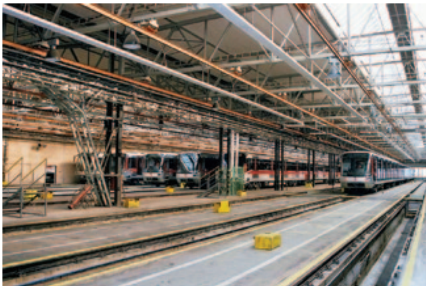
Рис. 3. В ремонтном цехе депо Качеров
